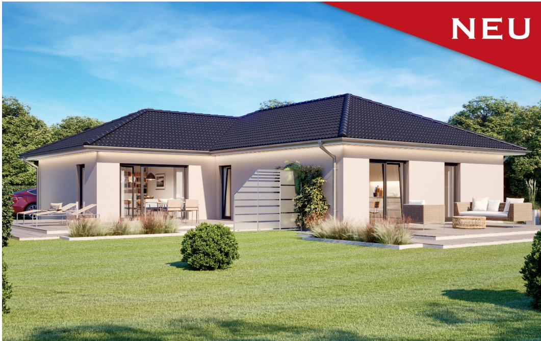
Fertighaus Mehrgenerationenhaus Bungalow SH 137 WB EW mit Panoramaverglasung (optional)
