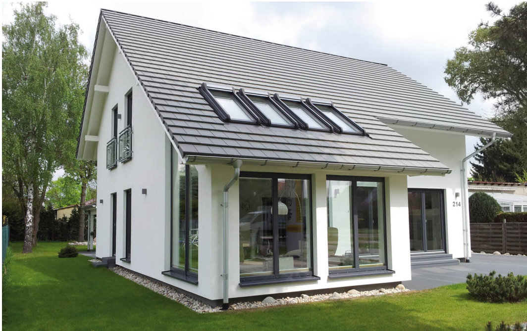
Fertighaus 1,5-Geschosser SH 160 Drempel
